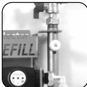
Druck durch Öffnen des Probeventils entlassen.
