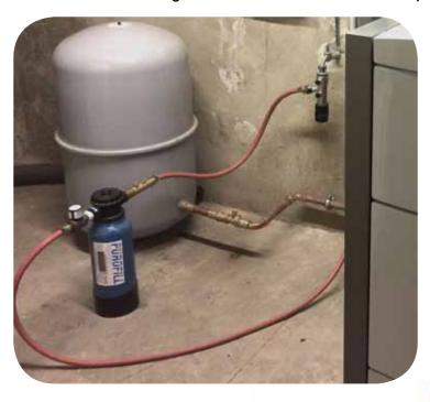
Die Befüllung von Heizungsanlagen mit vollentsalztem Wasser zählt heutzutage zu einem Quasi-Standard, um die Anlagen in Leistung und Wert zu erhalten.
